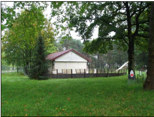
Te slopen gebouw van de speeltuin
