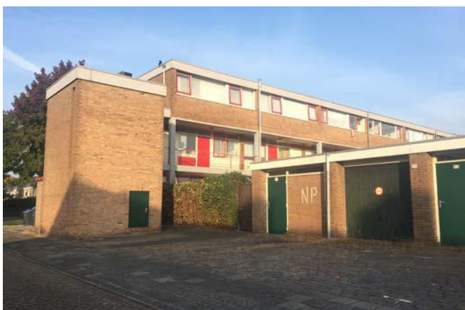
Achterzijde van appartementencomplex met garageboxen
