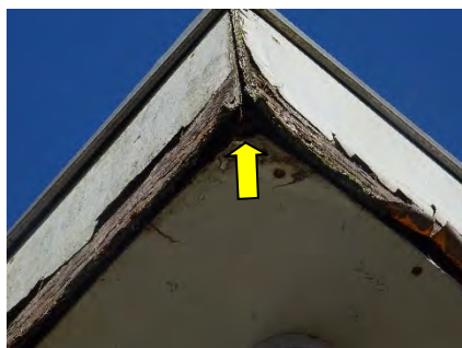
Figuur 5.3 Opening in boeiboord.
