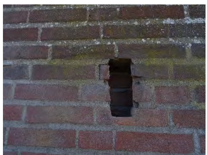
Figuur 5.6 Opening naar spouwmuur.
