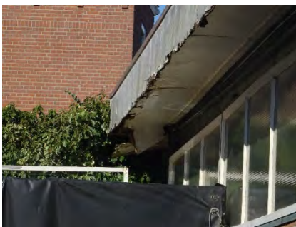
Figuur 5.4 Beschadigd boeiboord.
