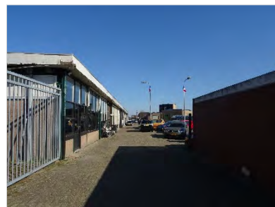
Figuur 2.8 Zuidwestzijde onderzoekslocatie.
