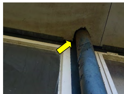
Figuur 5.5 Doorgang in boeiboord bij de regenpijp.
