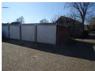
Figuur 2.6 Zuidwestzijde onderzoekslocatie.
