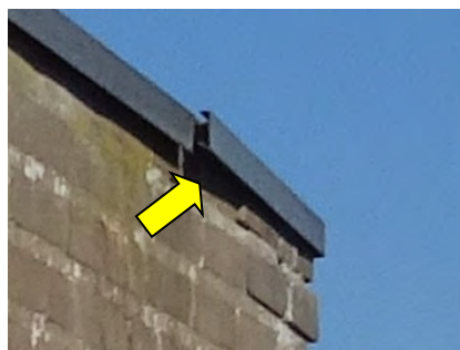
Figuur 5.7 Ruimte onder daklijst.
