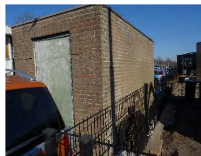
Figuur 5.8 Losstaand bakstenen gebouw.
