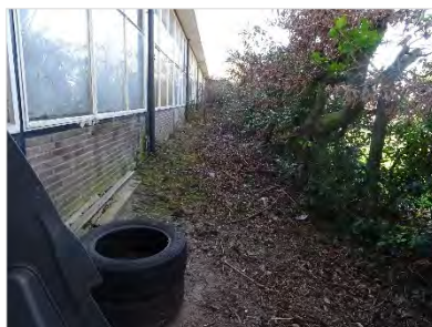
Figuur 2.4 Achterzijde gebouw.
