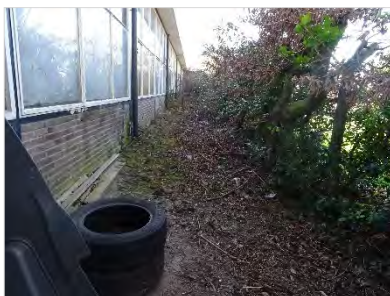
Figuur 2.3 Achterzijde gebouw.
