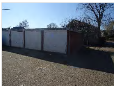
Figuur 2.5 Zuidwestzijde onderzoekslocatie.
