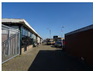
Figuur 2.7 Zuidwestzijde onderzoekslocatie.
