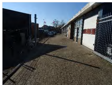
Figuur 2.4 Voorzijde gebouw
