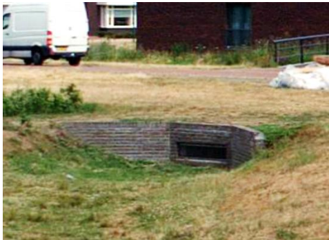
Figuur 2-3: Overstortconstructie wadi
