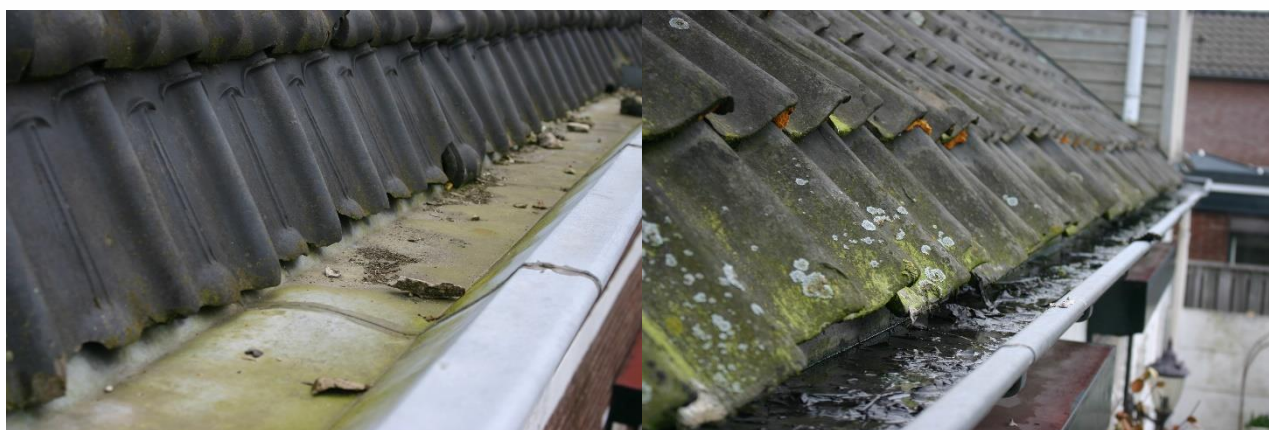
Figuur 4.4.4. De onderste rij dakpannen staat dusdanig steil in de dakgoot dat de ruimte eronder ongeschikt is voor huismusnesten (links). Onder de dakpannen bij nr. 28 (rechts) is geen toegang voor huismussen tot het dak. Overige openingen tussen dakpannen zijn lang geleden afgedicht met pur. Hierdoor is dit gebouw ongeschikt voor huismusnesten.
