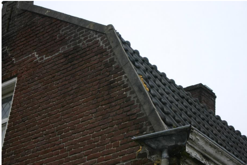
Figuur 4.4.1. De pannen op de zijgevels zijn met specie afgewerkt.
