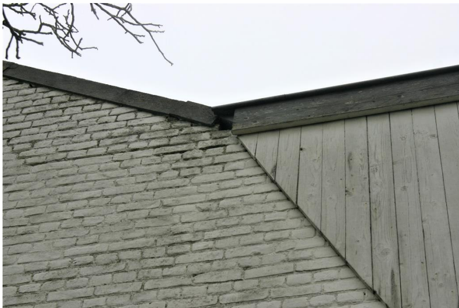
Figuur 4.4.2. uit inspectie met de boomcamera blijkt dat de houten dakkapel geen vleermuisverblijf bevat (zie tekst).
