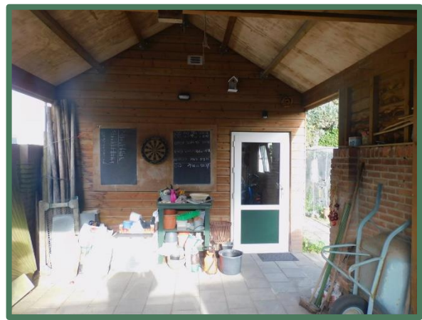
Te slopen garage binnenzijde
