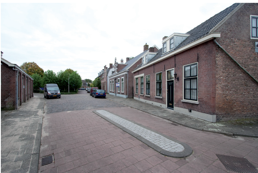
Afb. 45 De Heuvel met links de straatgevel van het oude ketelhuis.
