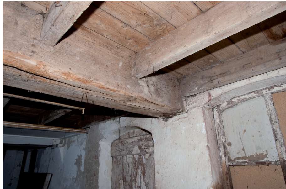
Afb. 16 Op de begane grond van bouwdeel A is het oudste deel te herkennen, omdat hier houten moerbalken aanwezig zijn. Op de achtergrond nog een oorspronkelijk raam en een oorspronkelijke deur.
