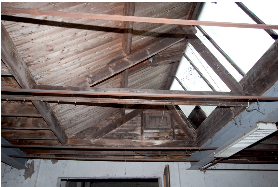
Afb. 37 Een als shed uitgevoerde lichtkap in het platte dak van bouwdeel J.
