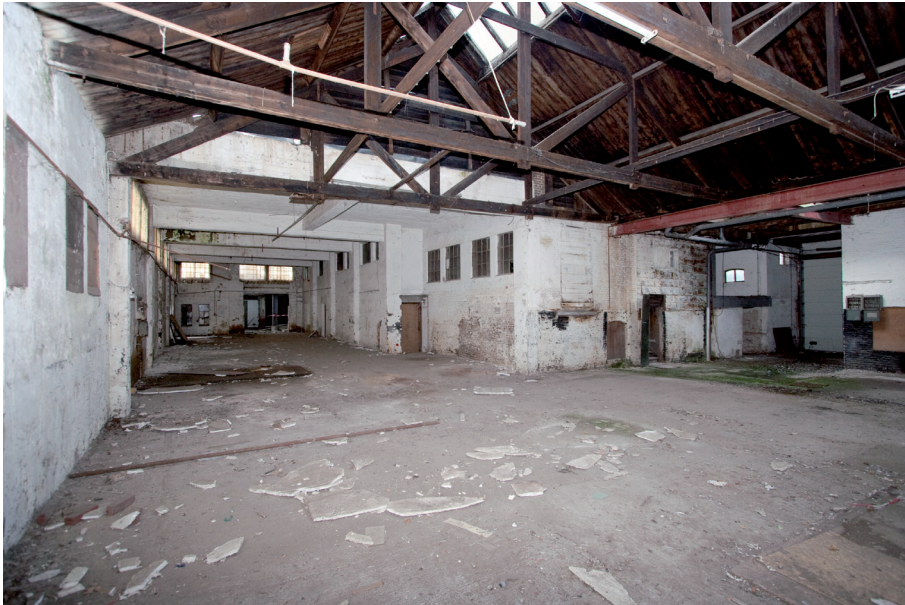
Afb. 28 De kapconstructie van bouwdeel E met op de achtergrond bouwdelen B en I.
