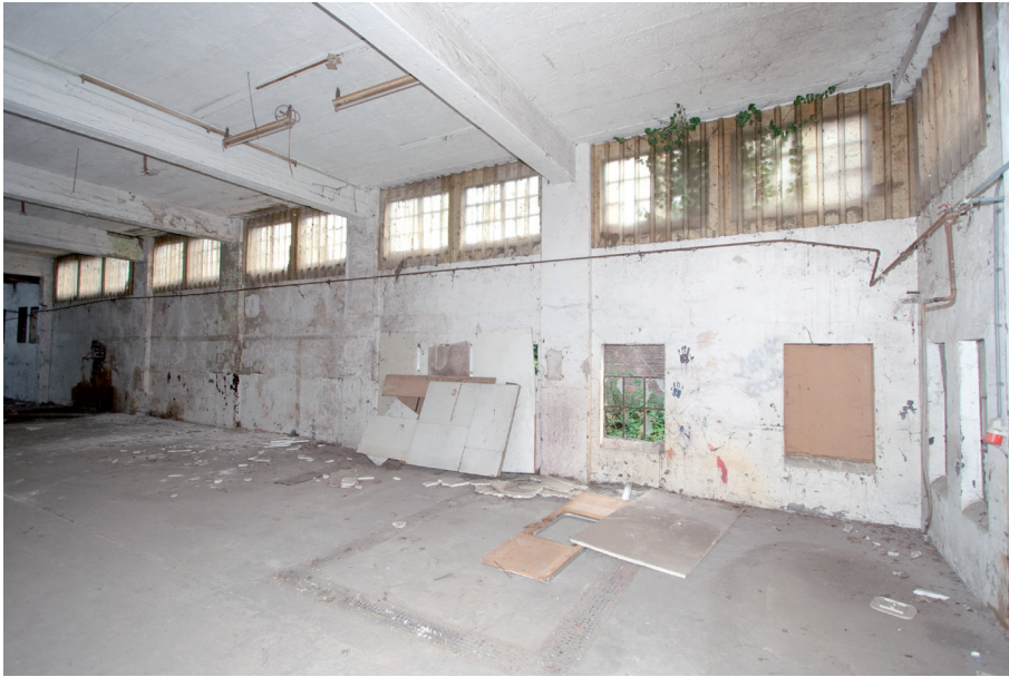
Afb. 34 De betonconstructie van bouwdeel I gezien in de richting van de gevel aan de Donge.
