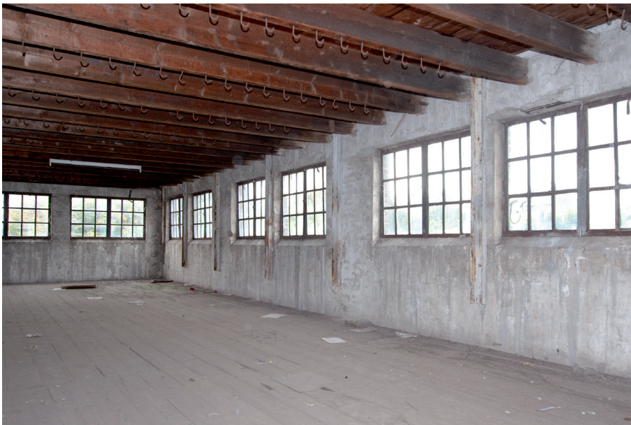
Afb. 31 De tweede verdieping van bouwdeel F, gezien in de richting van de Heuvel. Oorspronkelijke, stalen vensters en leerhaken in de kinderbinten.
