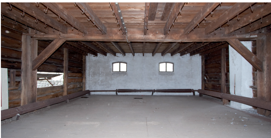
Afb. 22 Overzicht van één van de verdiepingen van bouwdeel B, richting de achtergevel (met oorspronkelijke vensters). Verder de drooginstallatie langs de randen en de leerhaken aan de kinderbinten. Links staat één van de ventilatieluiken open.
