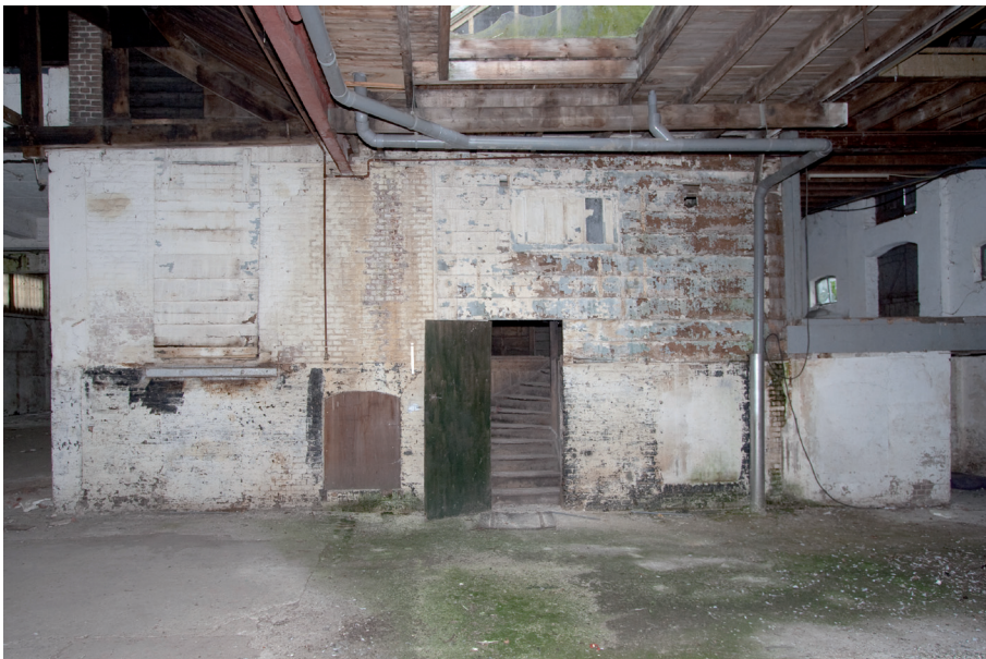
Afb. 18 De linker zijgevel van het bouwdeel B met nog deels de houten beplanning. De deuropening is toegevoegd na het verplaatsen van de trap. Verder nog enkele dichtgezette vensteropeningen.
