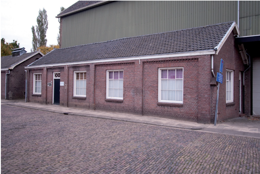
Afb. 24 Bouwdeel C, ogenschijnlijk één geheel, doch de huidige situatie is in drie fasen tot stand gekomen.
