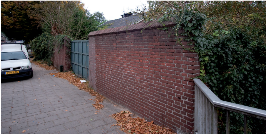
Afb. 40 De fabrieksmuur aan de zijde van de Rijensestraatweg.
