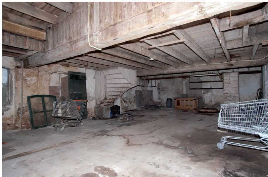
Afb. 19 De begane grond van bouwdeel B met zicht op de verplaatste trap en enkele vensteropeningen met oorspronkelijke ramen.
