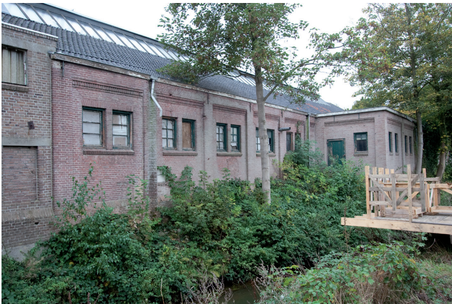
Afb. 29 Het exterieur van bouwdeel E, aan de Donge.
