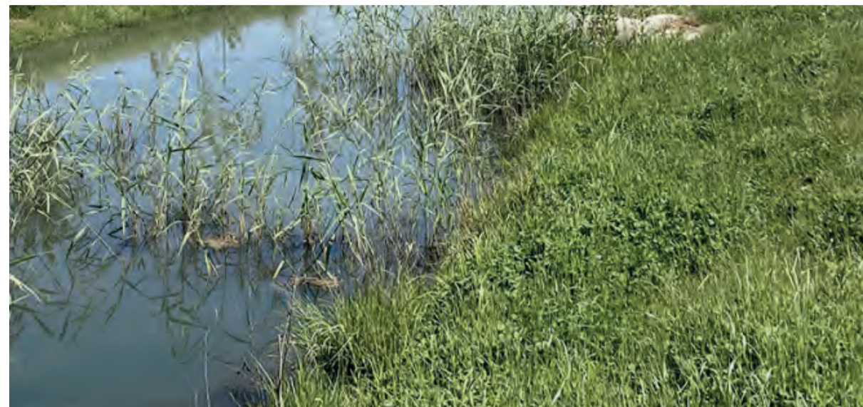
Wadi met flauw talud
